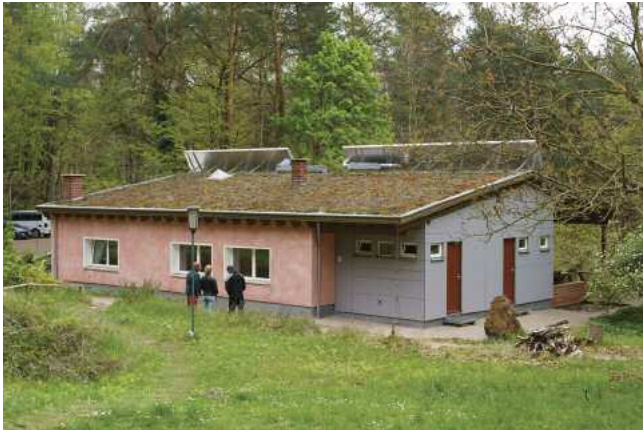
Das HeubachHaus zeigt sich mit neuer Fassade. Es wurden hierfür die ehemaligen Platten der Südwand des AuK wiederverwendet. Foto: Doris Ihlefeld
